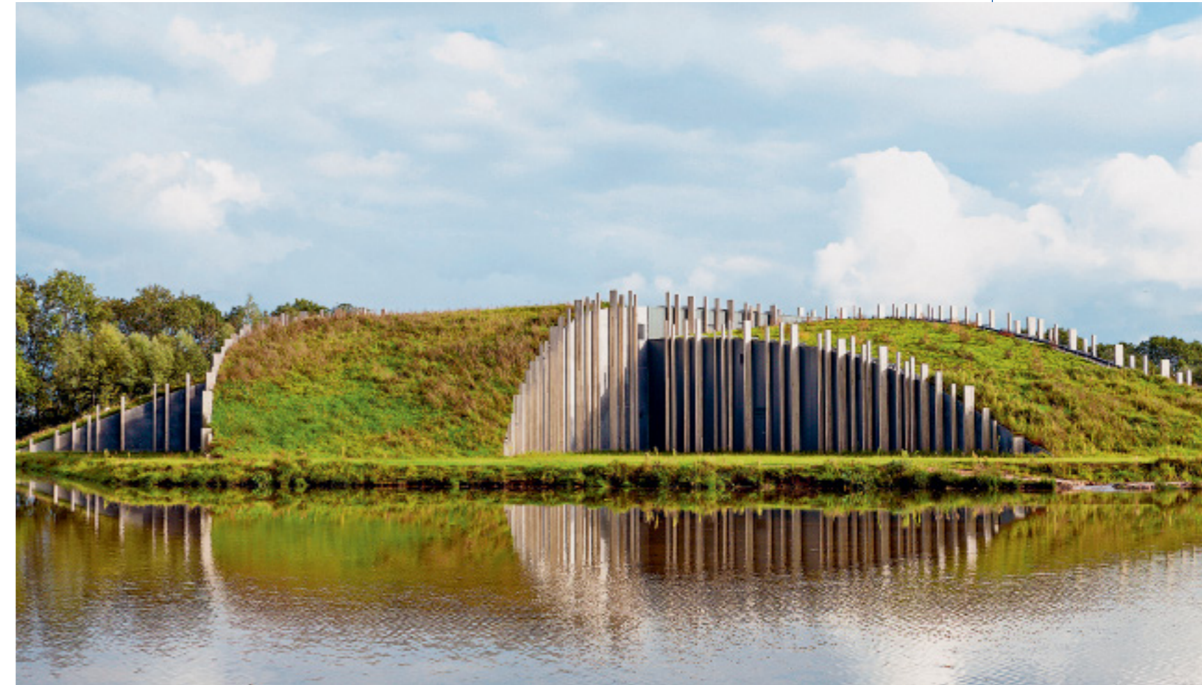
Productiebedrijf Vechterweerd aan de Vecht bij Dalfsen, waar oeverfiltratie wordt toegepast.
