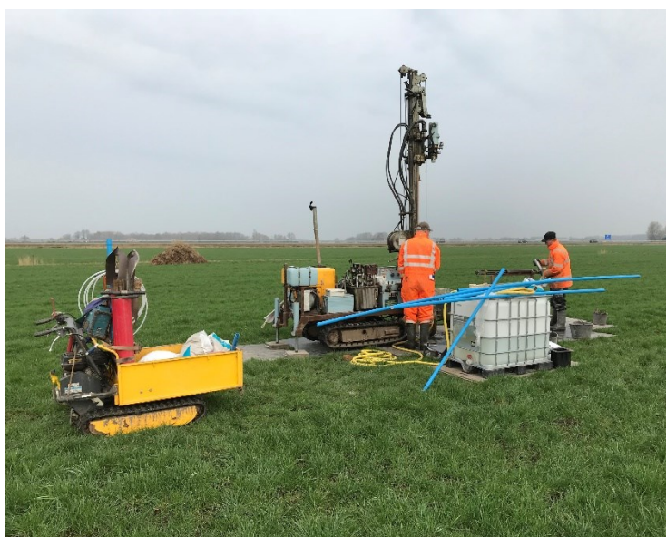
Sonderen en aanleg peilbuizen
