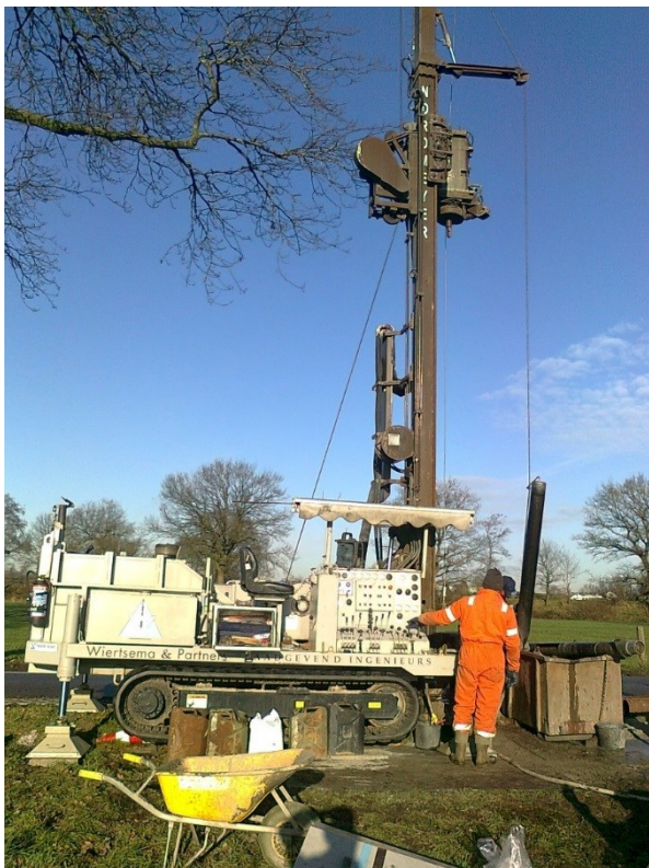
Aanleg diepe waarnemingsput
