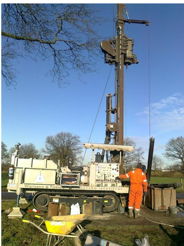
Aanleg diepe waarnemingsput
