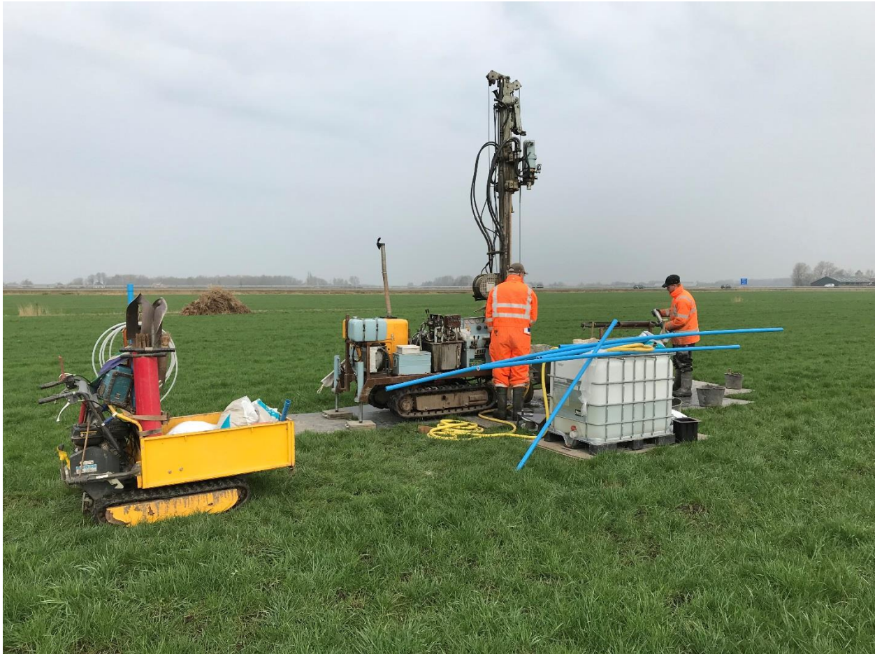
Foto 3: maken waarnemingsput in omgeving Luxwoude voor meting van grondwaterstanden
