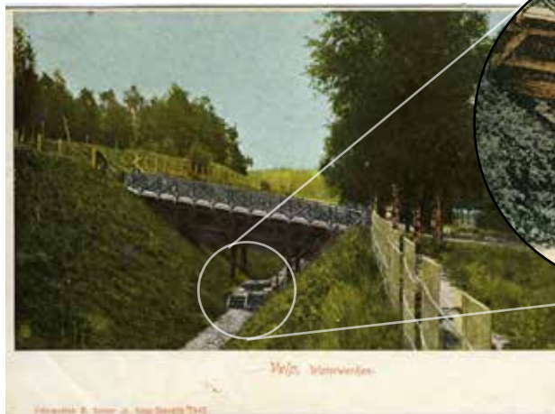
Prise d'eau en brug naar Park Pinkenberg, 1904 (bron: Gelders Archief, JH Schaefer, 1514-632)
