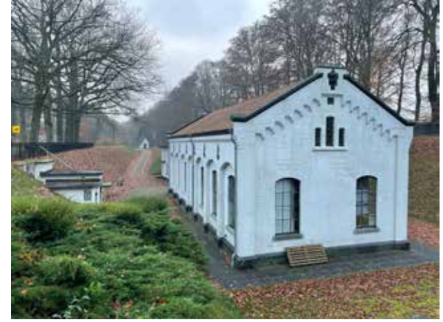
verlaagd pompegebouw, in gegraven kuil
