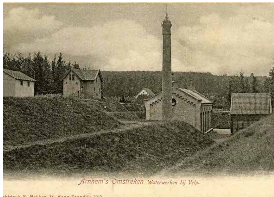
shtdruk S. Bakker Jz. Knoz-Zaandijk 7012 Pompstation en bijgebouwen in prise d'eau (bron: tijdbeeld.com)
