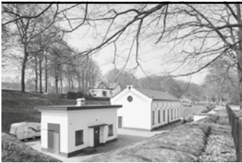
1926: pompegebouw met berging
